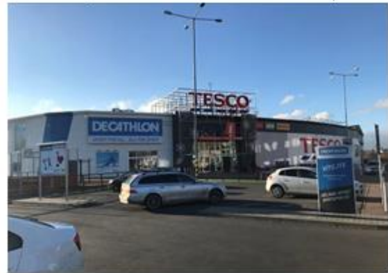
Celkový pohled na obchodní centrum
