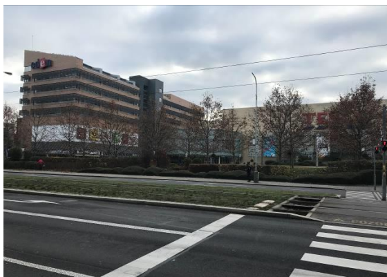
Celkový pohled na nákupní centrum, vlevo administrativní část
