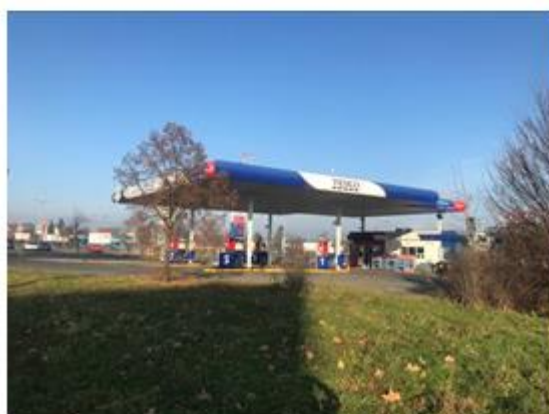
Čerpací stanice pohonných hmot
