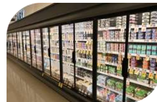
Přestavěná prodejna Stop & Shop s novým chladicím systémem.
